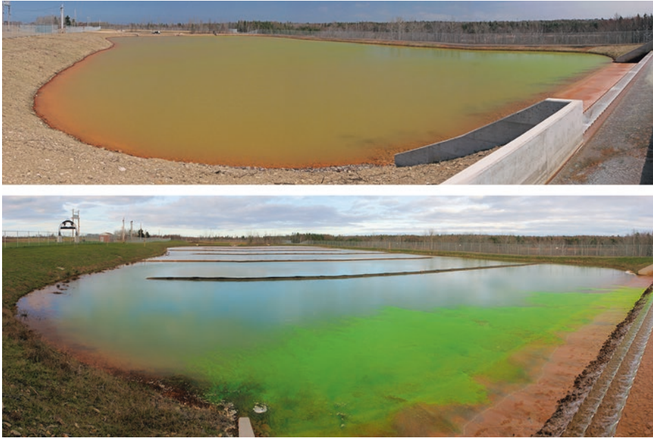
Abb. 4.16 Absetzbecken der passiven Grubenwasserreinigungsanlage Neville Street, Neuschottland, Kanada, vor und nach der Installation von Leitfolien. Details in Wolkersdorfer (2011)
