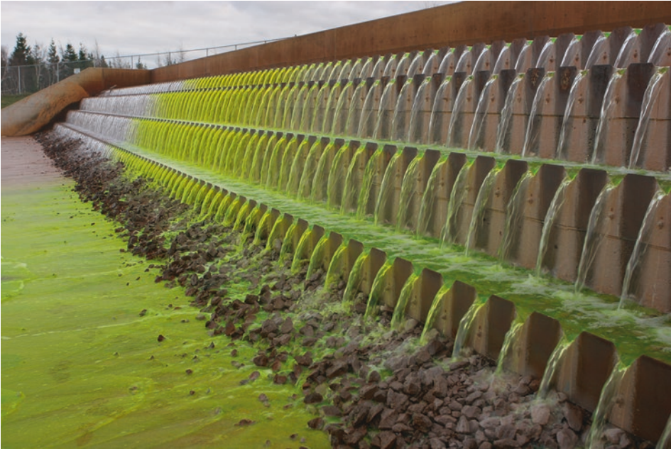
Abb. 4.23 Oxidationskaskade der passiven Grubenwasserreinigungsanlage Neville Street, Neuschottland, Kanada, während eines Tracertests mit Uranin. Durchfluss etwa 1 \text{ m}^3 \text{ s}^{-1} ; Höhe der einzelnen Kaskadenstufen etwa 0,6 m
