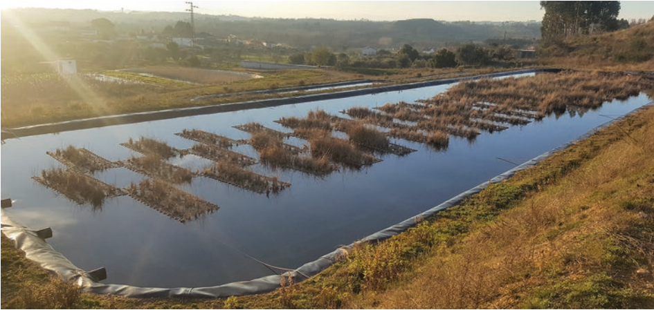
Abb. 4.26 Makrophytenbecken eines ARUM-Systems am ehemaligen Uranbergwerk Cunha Baixa (Portugal). Im System werden Eisen, Uran und Radium zurückgehalten
