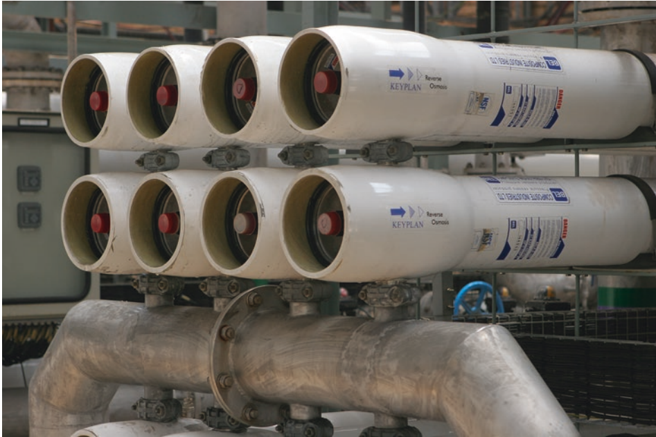
Abb. 3.20 Umkehrosmoseeinheit der Grubenwasserreinigungsanlage eMalaheni in der Provinz Gauteng/Südafrika (vgl. Abb. 7.7)
