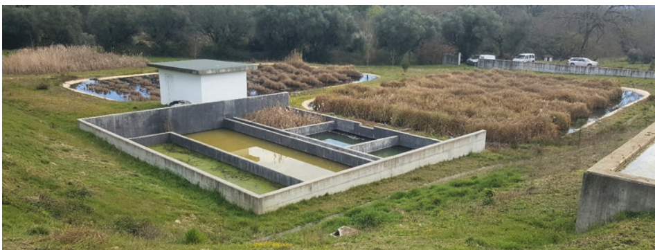
Abb. 4.4 Absetz- und Makrophytenbecken sowie – heute nicht mehr notwendiges – Aktivkohlefilterbett und aerobes Feuchtgebiet am Uranbergwerk Urgeirica (Portugal). Das Grubenwasser ( Q \approx 90 \text{ Lmin}^{-1} ) fließt von rechts nach links, und der pH-Wert wird im Mittel von etwa 6 auf 8 angehoben. Im System werden Eisen, Uran und Radium zurückgehalten
