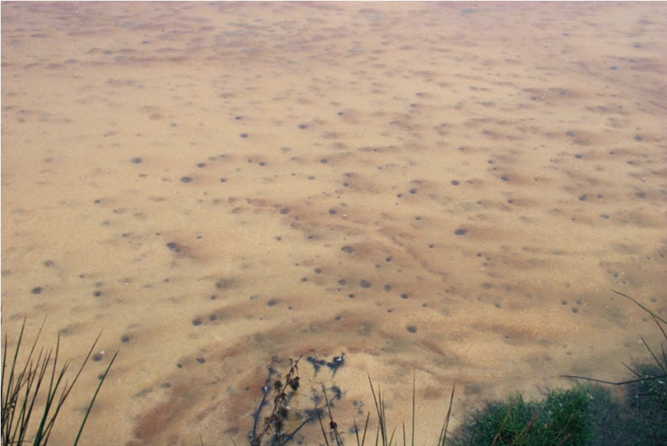
Abb. 4.12 Durch Gasauftstieg hervorgerufene Kanäle auf der Oberfläche des mit Eisenoxihydraten bedeckten organischen Substrats im RAPS Bowden Close, Landkreis Durham, England. Durchmesser der Kanäle im Zentimeterbereich; Bildbreite in der Mitte etwa 3 m
