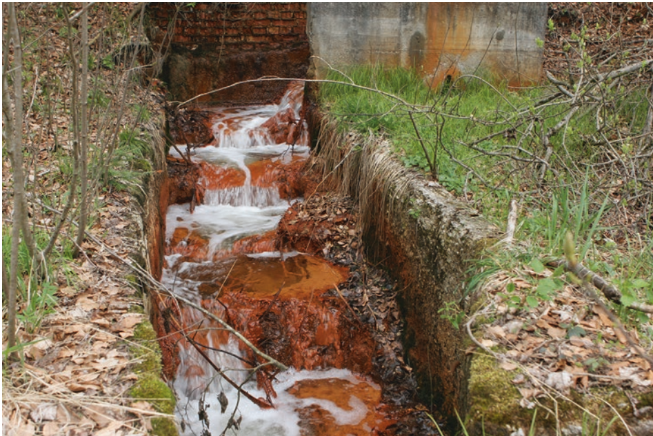
Abb. 4.22 Oxidationskaskade des Ventilatorstollens an der Leitzach, Oberbayern. Durchfluss etwa 2 \text{ m}^3 \text{ min}^{-1} . Breite des Kanals etwa 1 m. Zwischenzeitlich völlig umgebaut
