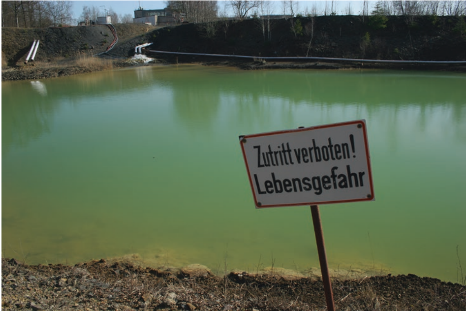
Abb. 4.15 Absetzteich an der ehemaligen Grubenwasserreinigungsanlage Straßberg/Harz. Die Grünfärbung wird vor allem durch suspendierten Kalkstein hervorgerufen
