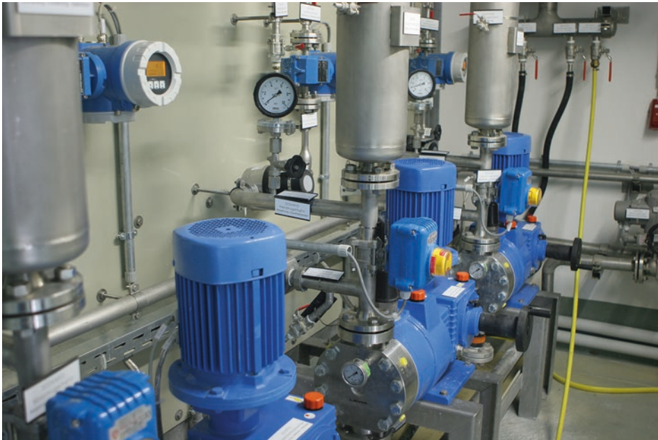
Abb. 3.2 Pumpen für die Chemikalienzufuhr in einer aktiven Grubenwasserreinigungsanlage (Straßberg/Harz)
