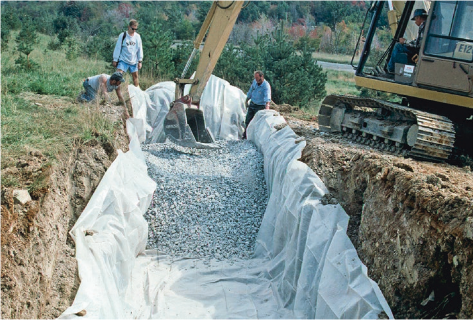
Abb. 4.5 Anoxischer Carbonatkanal während der Konstruktionsphase. Im offenen Kanal befindet sich die Dichtungsfolie, und am hinteren Ende ist der Kanal bereits mit Kalkstein gefüllt (Foto: Jeff Skouson)
