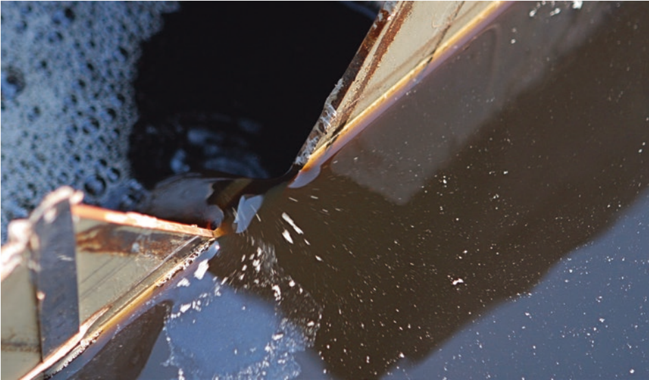
Abb. 2.10 Falsch installiertes Messwehr an der ehemaligen IMPI-Pilotanlage Middleburg in der Provinz Gauteng, Südafrika. An der Wehrplatte fehlt die abgeschrägte, wasserseitige Abrisskante
