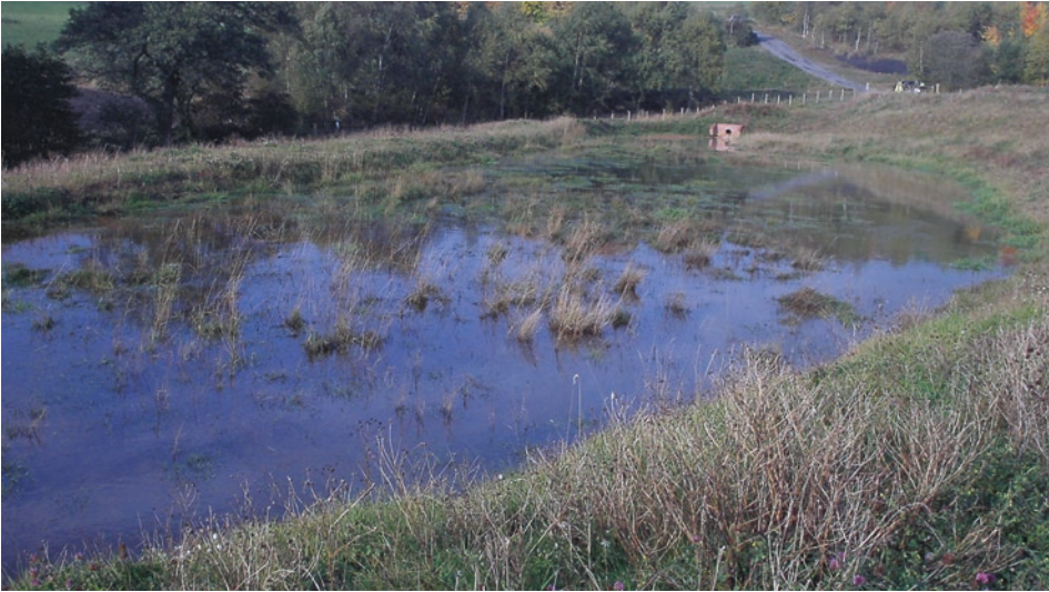
Abb. 4.14 RAPS II am Standort Bowden Close, Landkreis Durham, England, Blickrichtung Westen. Auf dem Substrat aus Kalkstein und Pferdemist wachsen durch Sukzession typische Feuchtgebietspflanzen. Außerhalb des Bildes rechts befinden sich das RAPS I und links das konstruierte Feuchtgebiet
